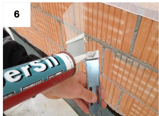
Flex-Schiene abdichten und montieren
