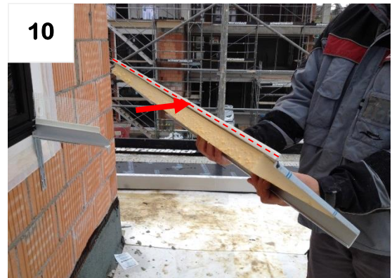
Dichtband anbringen
