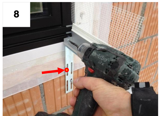
Flex-Schiene an den Fensterrahmen befestigen und die zweite Schraube (beim Montagebügel) fixieren
