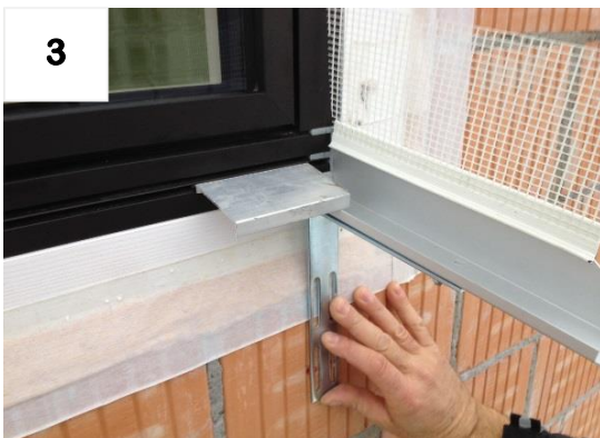
Montagehöhe mit Wetterschenkel definieren
