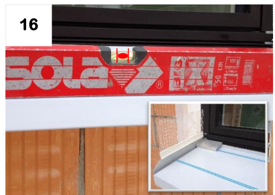
Kontrolle der Montagearbeiten
