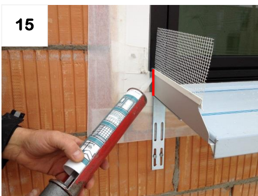
Übergang Flex-Schiene/Fensterrahmen (L+R) abdichten
