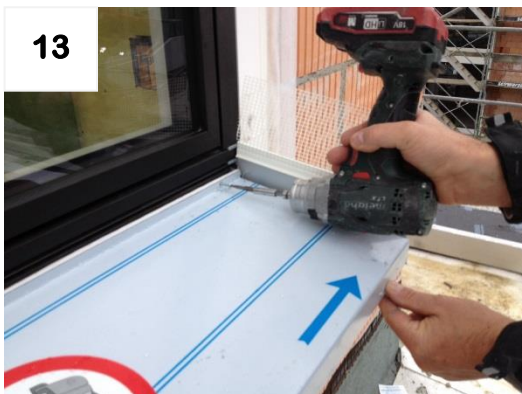
Fensterbank „leicht“ anschrauben (muss beweglich bleiben)
