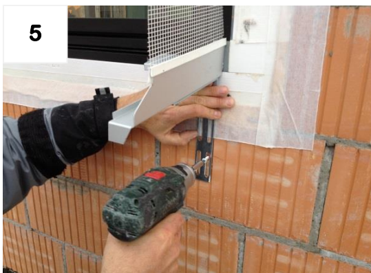
1x Schraube (provisorisch) fixieren
