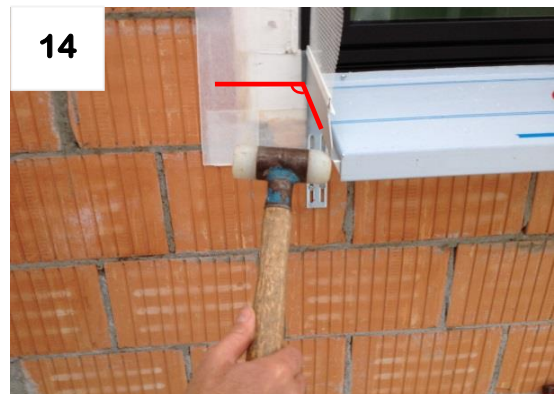
Flex-Schienen ausrichten (90° zum Fenster)
