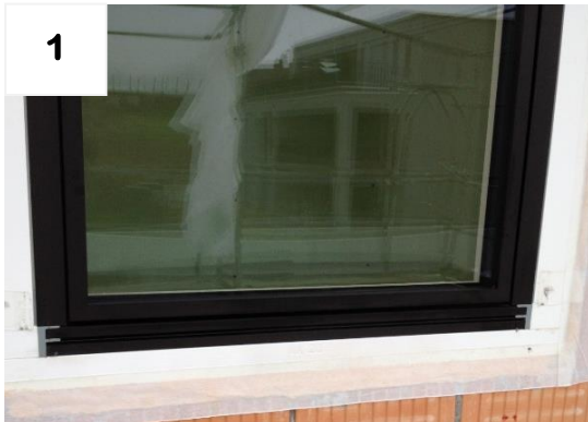
Ausgangslage: Fenster montiert + abgedichtet
