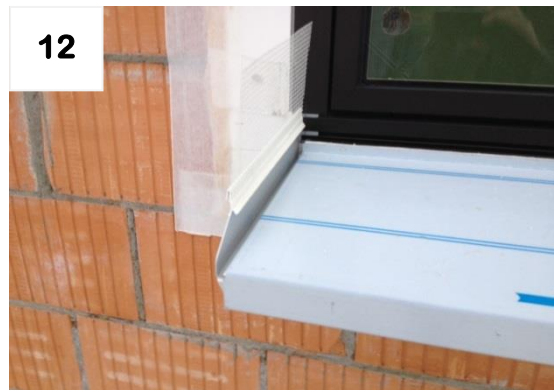
Fensterbank zwischen den Flex-Schienen ausrichten
