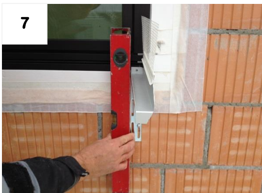
Flex-Schiene ausrichten
