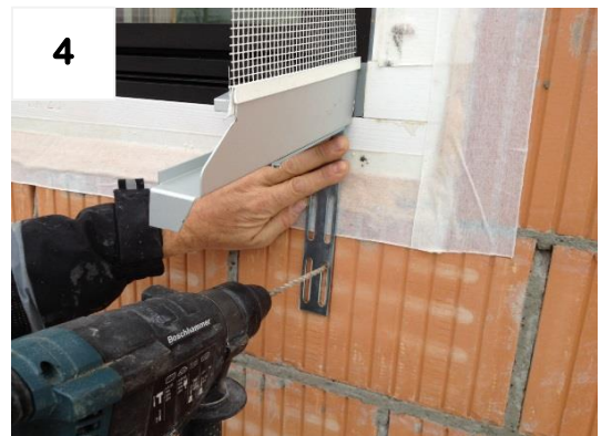
1x Befestigungsloch bohren
