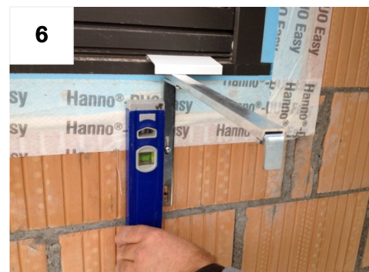
Bügel ausrichten und erste Schraube fixieren
