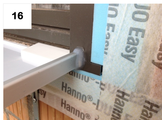
Seitlicher Fensterrahmen-Anschluss abdichten
