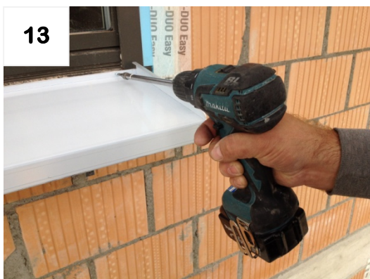
Bank „leicht“ anschrauben (muss beweglich bleiben)
