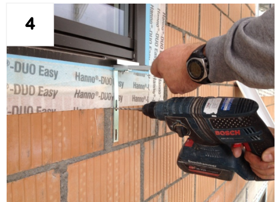
1x Montageloch bohren
