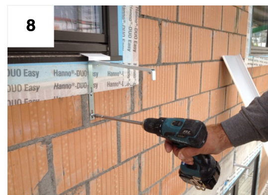
Zweite Schraube fixieren
