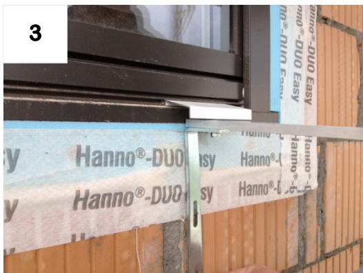
Montagehöhe mit Wetterschenkel definieren
