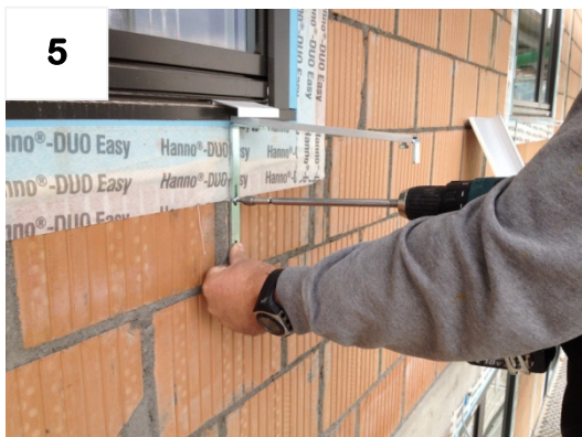
1x Schraube (provisorisch) fixieren
