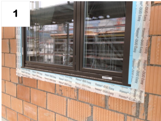
Ausgangslage: Fenster montiert + abgedichtet
