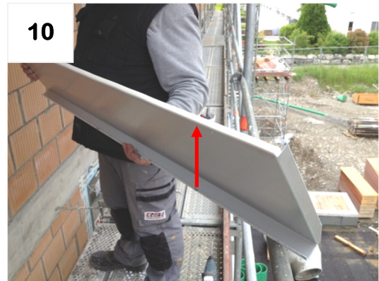
Dichtband anbringen
