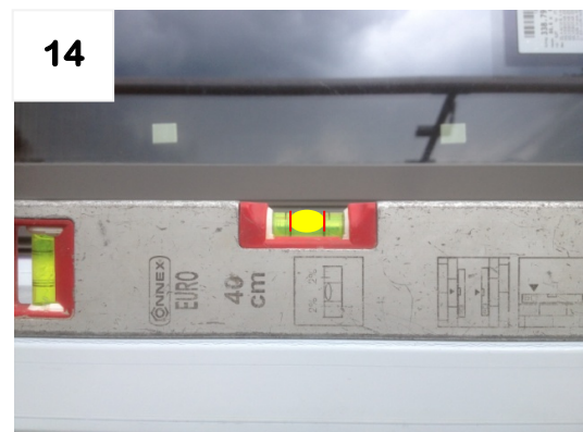
Kontrolle der Montagearbeiten
