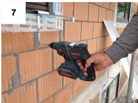
Zweites Loch bohren
