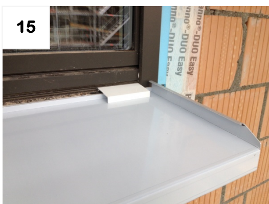
Einbauhöhe mit Wetterschenkel überprüfen (L+R)
